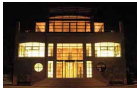
Siedziba firmy w Monachium
